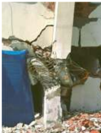
Slika 2, slom nepravilno armiranog AB stuba od uticaja zemljotresa
